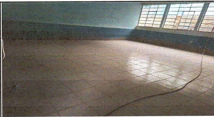
Foto 3: Finalizado 100% remozamiento de pisos en las aulas
