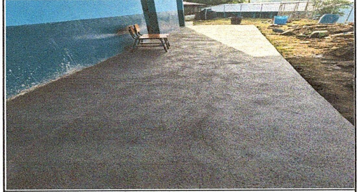
Foto 2: Finalizado 100% remozamiento corredor modulo 2
