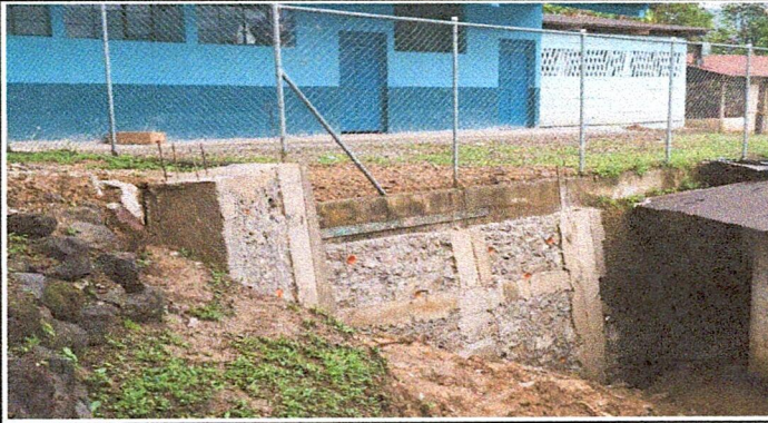
Foto 1: Finalizado 100% de remozamiento del muro de contención del modulo 2
