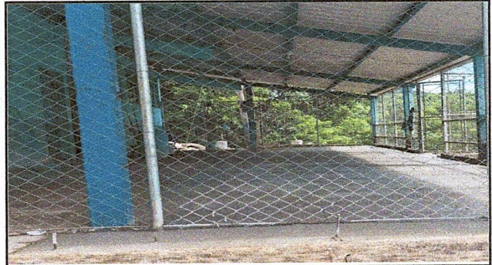
Foto 4: Finalizado 100% remozamiento corredor modulo 1
